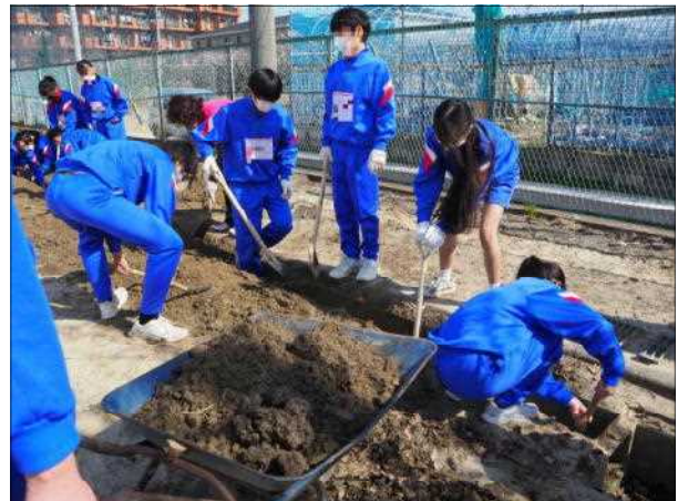
かき出した土は一輪車で運びます
