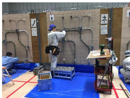
～電気工事競技～
