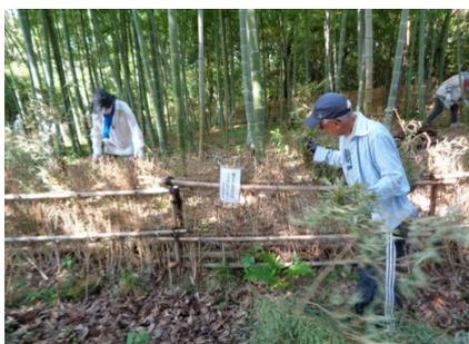
▼支柱(杭)を打込み、柵を補強。
